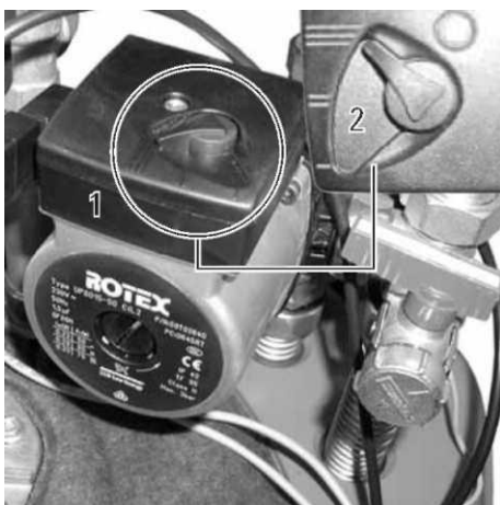
Slika 4-7 Namještanje stupnja snage crpke
